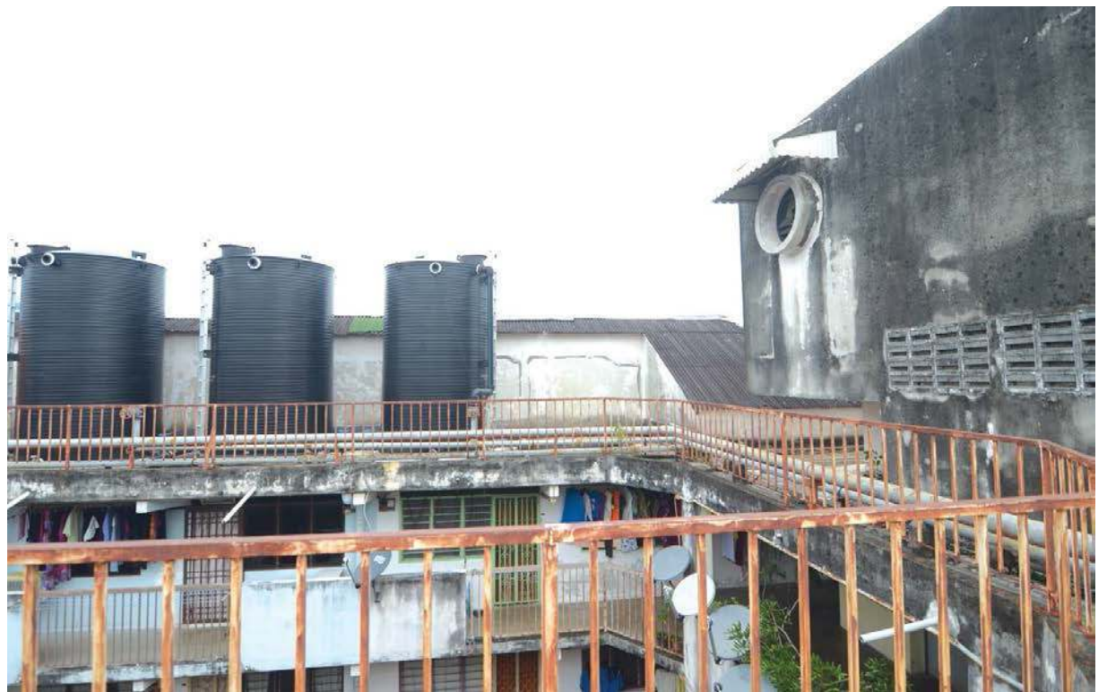
峇都兰樟Taman Sri Damai 3座组屋修理屋顶梓板获得州政府拨款维修。
