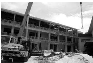
KEADAAN bangunan baru MBS yang dijangka siap pada Ogos 2010.
