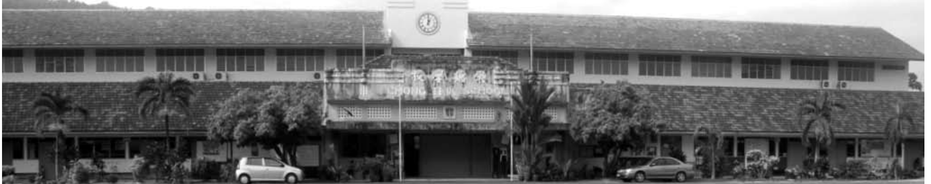
GABUNGAN bangunan lama (depan) dan bangunan baru SJK (C) Chong Teik, Balik Pulau.
