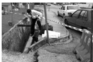
S. Raveentharan memeriksa keadaan tebing longkang yang hampir runtuh di Lorong Nipah 3 di sini.
