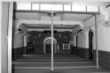
KEADAAN ruang utama masjid yang digantikan dengan alang baru.
