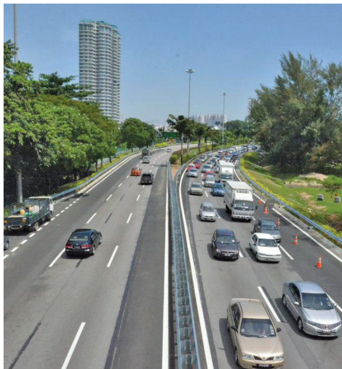
位于北马水警总部附近的400公尺敦林苍祐大道路段来回方向的加宽工程在耗时6个月已竣工，往返方向路段约400公尺的2条车道已加宽成3条车道，解决纠缠了民众10年的严重堵车梦魇。
