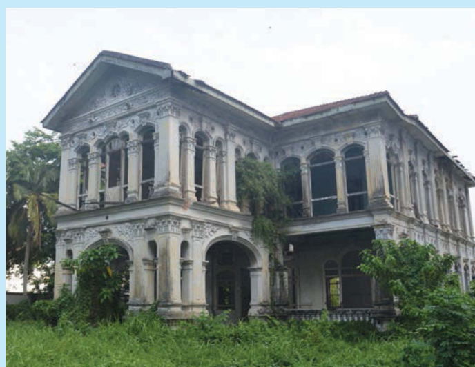
218号老屋的原料重建工程分为4个阶段，目前已进入第三阶段，那就是在拆除损坏的建筑结构后，再把这些建筑结构收藏在位于苏丹阿末沙路的仓库内，等第三阶段完成后，建筑商将以原料，或以尽量相似的建筑材料替代原本损坏的结构，并在原地重建。（摄影：岑健伟）
