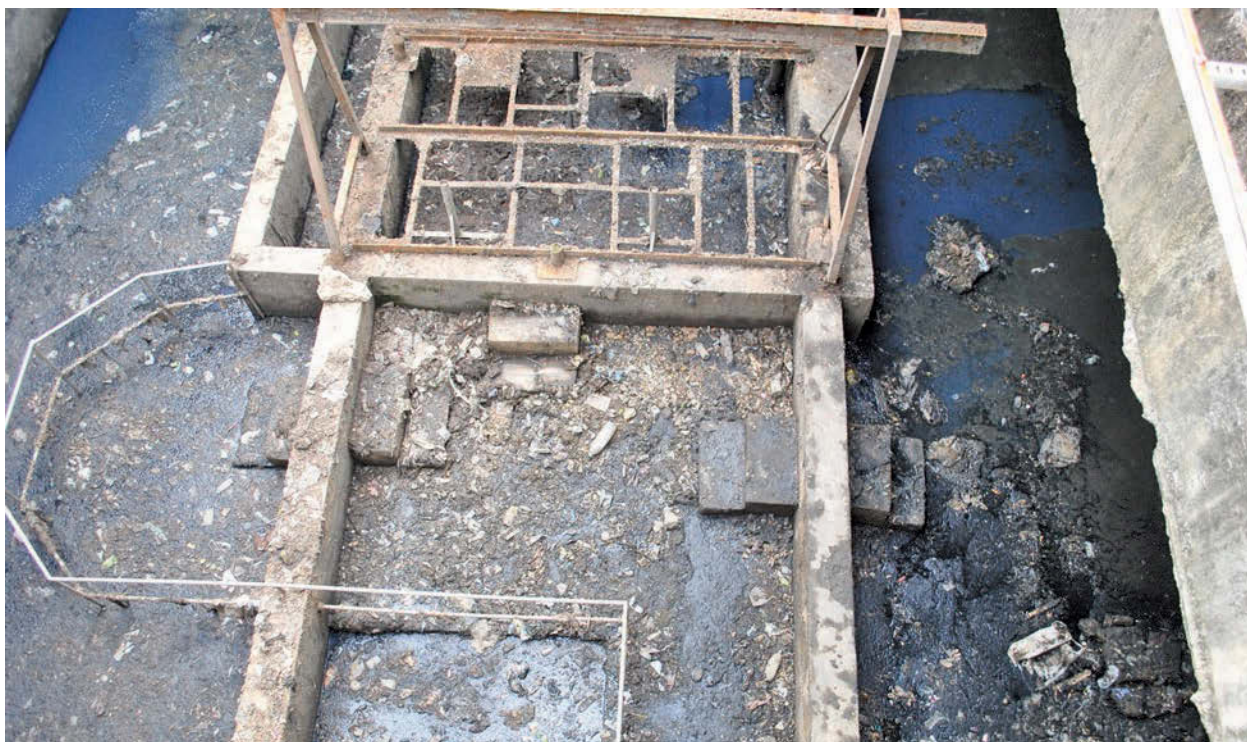
用于处理污水的化粪池出现各种固体垃圾，如塑料袋、塑料罐、玻璃瓶、铝罐等，就连大件固体垃圾如脚车及床褥都丢弃在化粪池，导致化粪池机件故障无法过滤污水。
