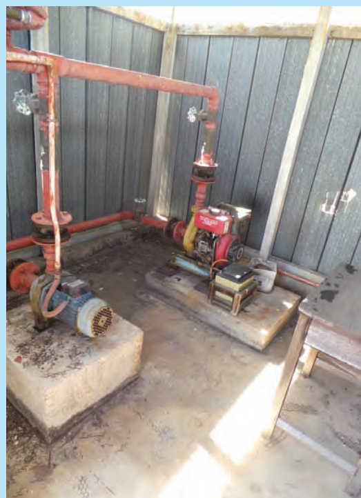
三民小学顶楼的软管卷盘泵组早已不能操作，校方担心万一火患发生时，它无法及时发挥救火作用。
