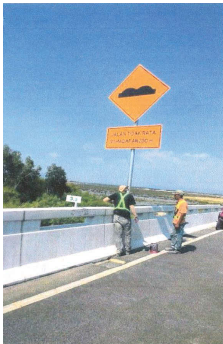
大桥路面出现凹凸不平的问题已构成公路使用者的威胁，所以维修工程刻不容缓。
