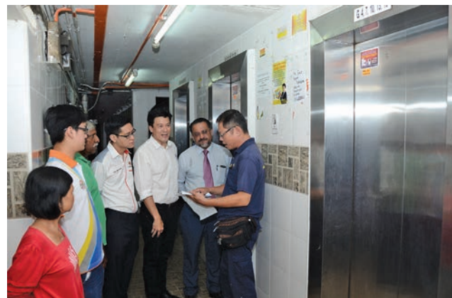
JAGDEEP Singh Deo (dua dari kanan), Cheah Kah Peng (tiga dari kanan) dan Zairil Khir Johari (tengah) mendengar penerangan daripada wakil kontraktor berhubung pemasangan lif baharu dekat Blok C, Perumahan Awam Kerajaan Negeri Padang Tembak di sini baru-baru ini
