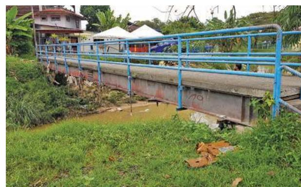
KESAN hakisan sungai di bawah jambatan yang menghubungkan Jalan Langkawi dan Jalan Gopeng.
