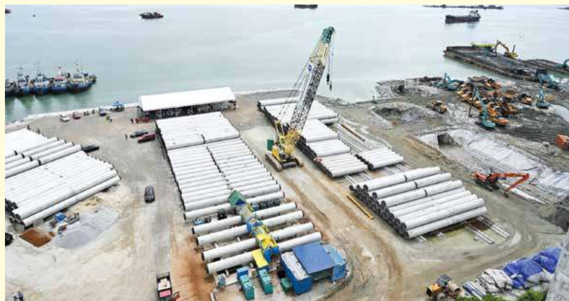
第三双管海底水管项目（3rd PTSP）目前工程进度达34%，预计明年杪竣工。
