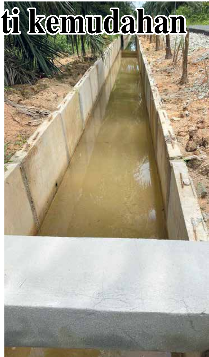
SISTEM perparitan yang turut dinaik taraf melalui pembinaan longkang ‘U’.
