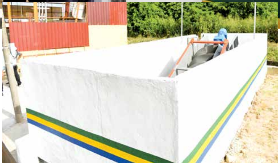
大山脚忠英园的排水泵及河堤提升工程已竣工。
