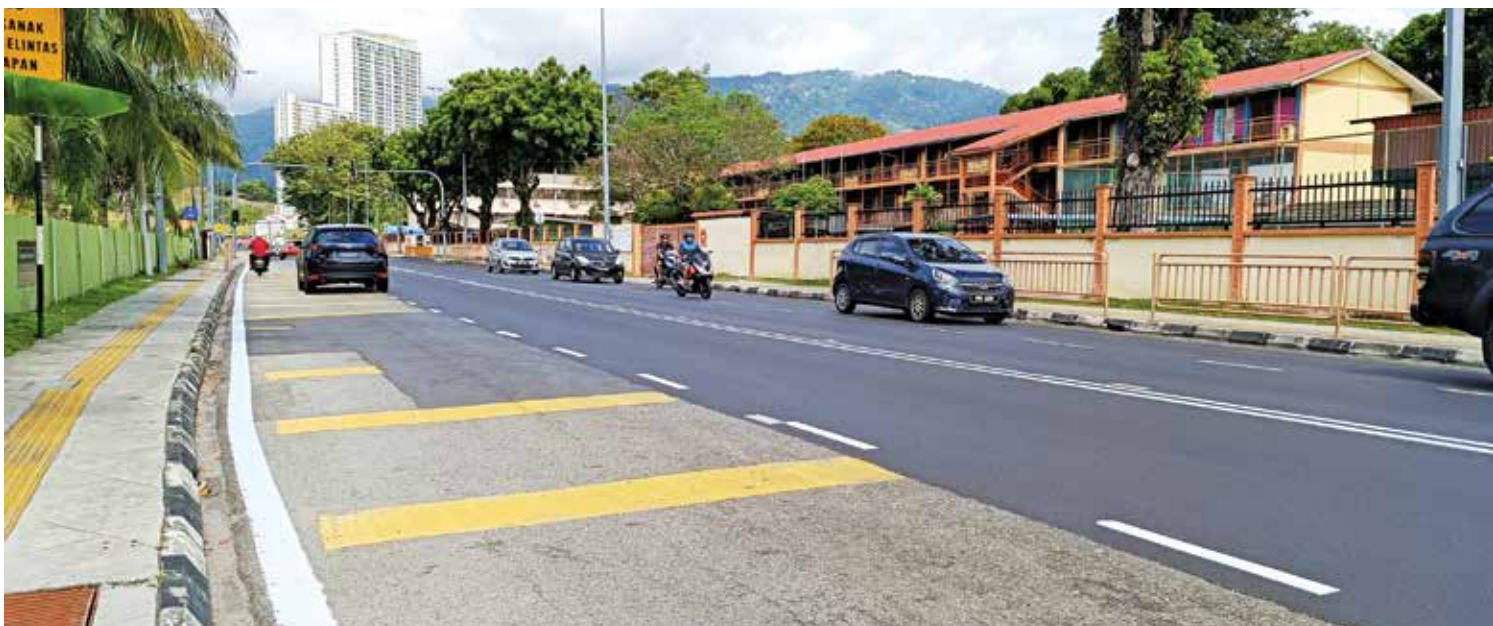
罗弄峇都兰樟部份道路，有待国能电缆连接工程完成后才能进行铺路工程。
