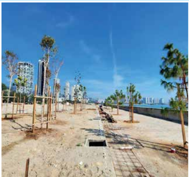
葛尼水岸第一阶段工程，已晋入园艺美化和植树的阶段。
