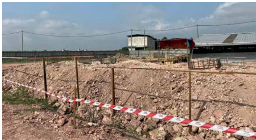
KERJA-kerja pembinaan Galeri Warisan Arkeologi Guar Kepah sedang giat dijalankan.
