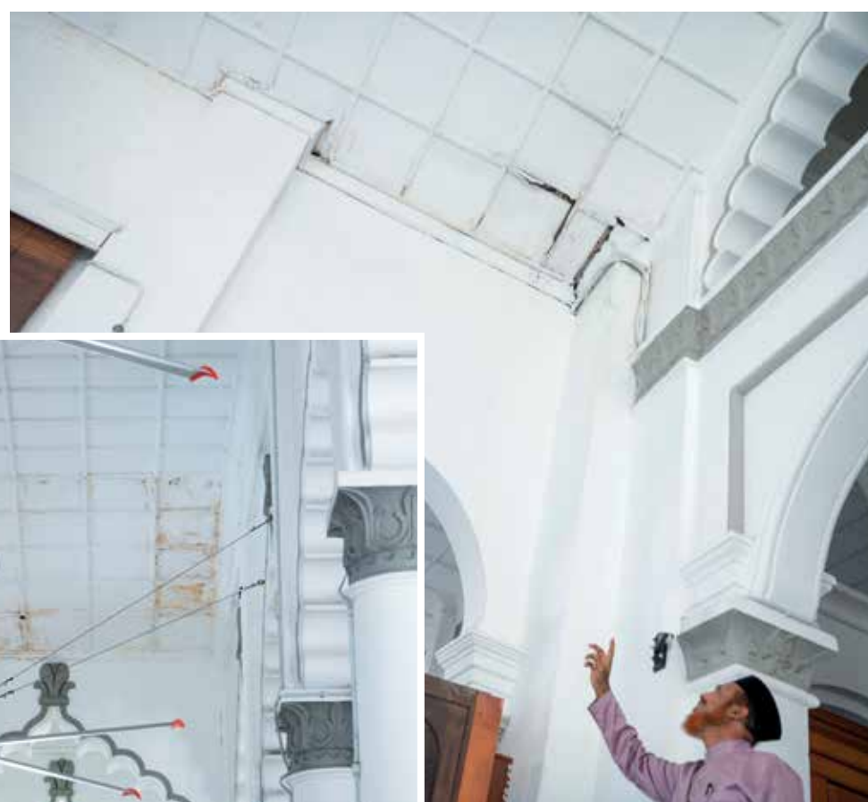
KEBOCORAN pada struktur bumbung yang dikesan.
