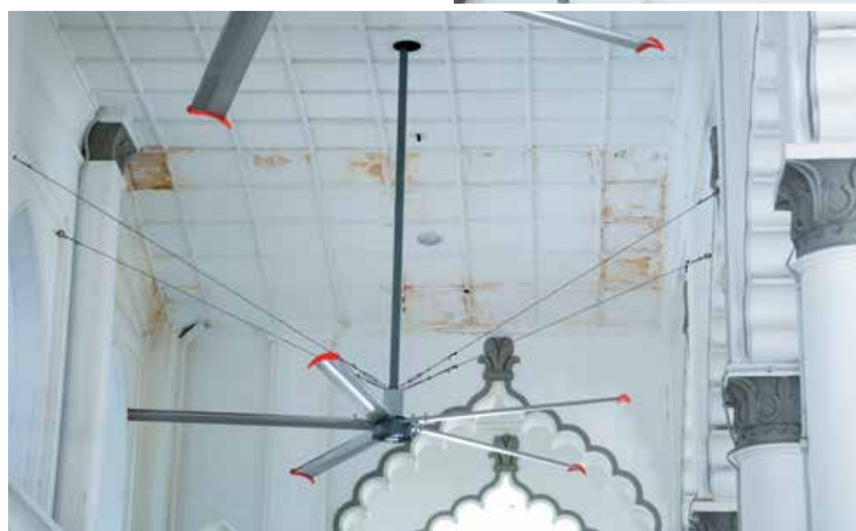
KEBOCORAN pada struktur bumbung yang dikesan.
