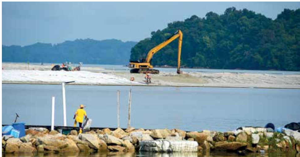
矽谷岛填海工程积极进行中。
