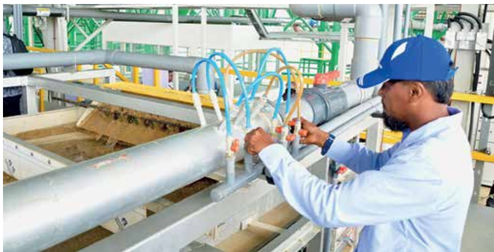
北海双溪赖滤水站脱水厂正式启用。
