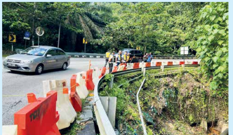
峇都丁宜斜坡修复工程顺利进行中。
