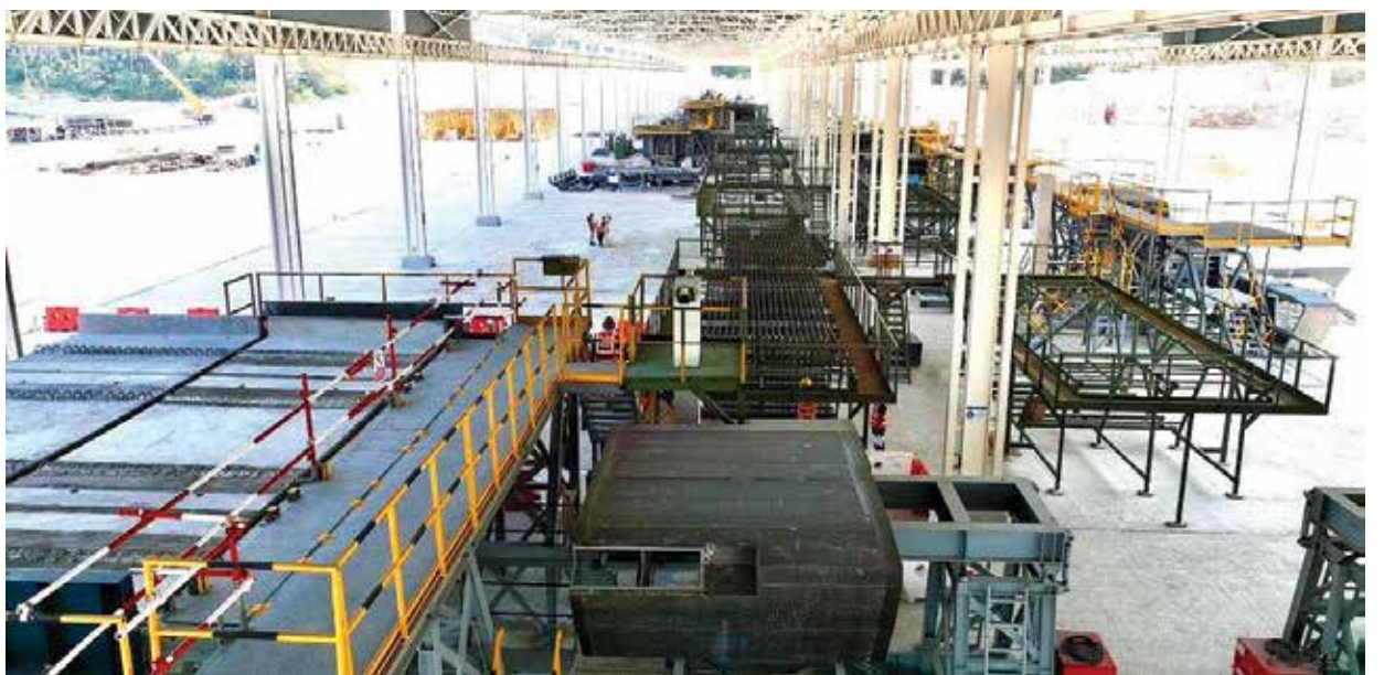
轻快铁配件先在工厂预制，再运送到施工地点安装。
