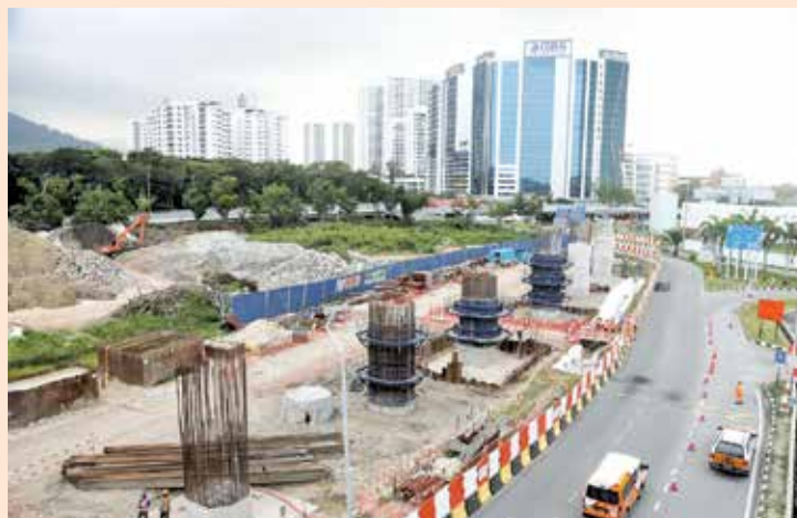
轻快铁国际机场站工地鸟瞰图。
