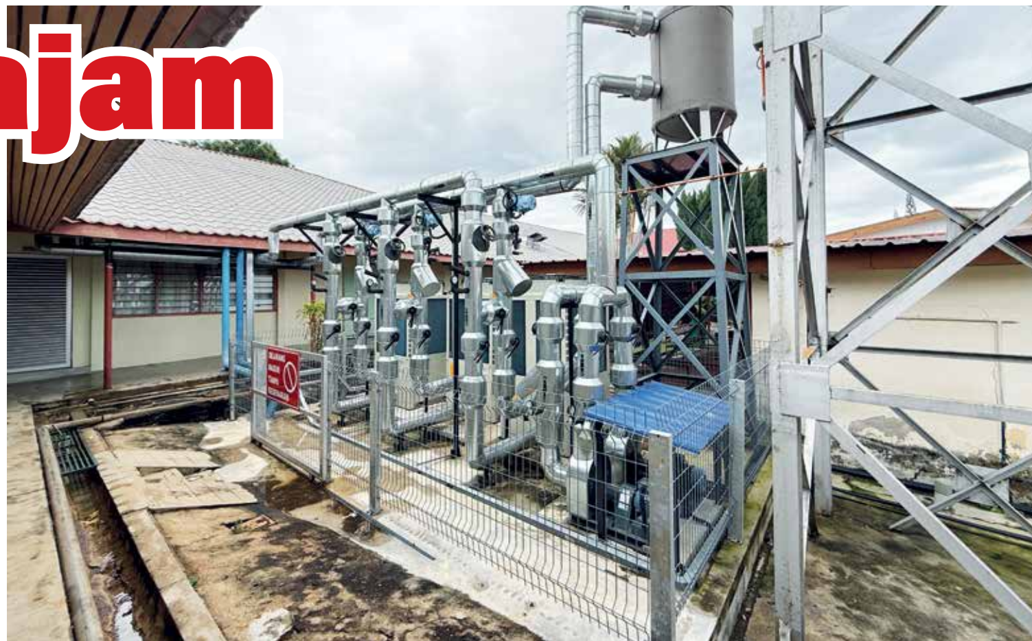
SISTEM pendingin hawa yang telah dinaik taraf untuk penjimatan tenaga.
