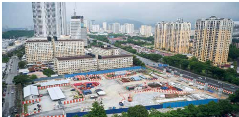
槟岛多项大型工程施工中，需要妥善安排周边问题避免影响交通。
