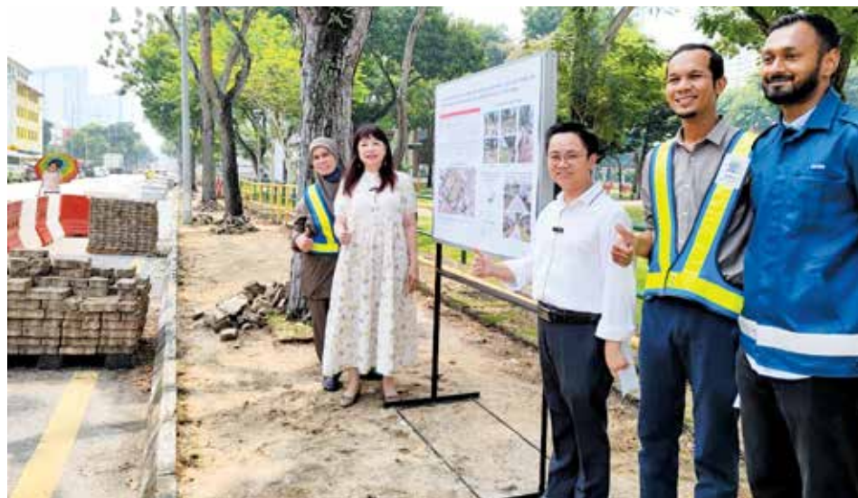
五条路邻里公园周边人行道与路肩，已展开提升工程。左二起为林慧英及王宇航。
