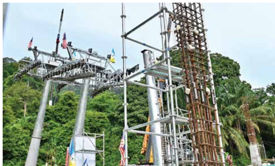
工程现场可见，空中吊缆的塔柱已成形。
