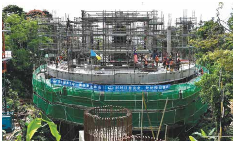
升旗山空中吊缆计划的实体工程，预计明年8月完成。
